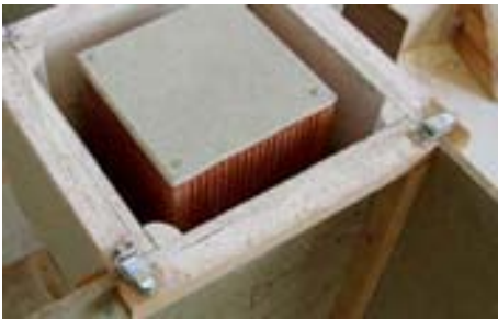
Mise en place de la brique linteau et de la plaque supérieure
