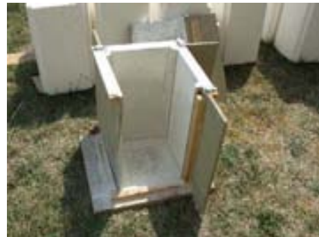
Assemblage des parois. Elles s'emboîtent les unes dans les autres.
