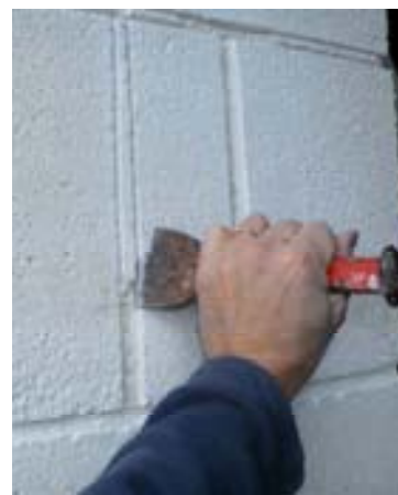
Evidement des joints
