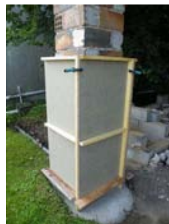
1er tronçon : 4 rangées de pierres
