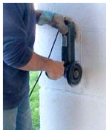
Ouverture au disque segmenté
