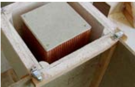
Mise en place de la brique linteau et de la plaque supérieure
