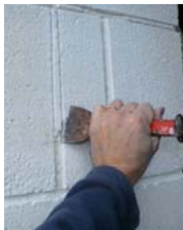
Evidement des joints
