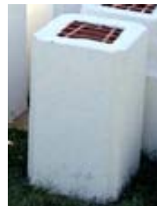
L'élément de pilier après démoulage et grattage.
