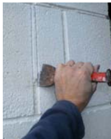
Evidement des joints
