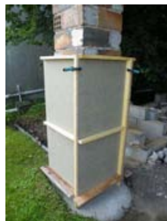
1er tronçon : 4 rangées de pierres
